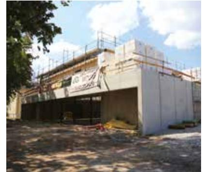
Le clôt-couvert du gymnase scolaire a été posé début septembre précédé de la réalisation de travaux d'étanchéité de la toiture. Fin août, les menuisiers ont posé les châssis extérieurs pour fermer complètement le bâtiment. Sont ensuite programmés les travaux de second œuvre (électricité, sanitaire, chauffage, plâtrier...). La livraison du bâtiment est prévue pour fin d'année 2018. ■
